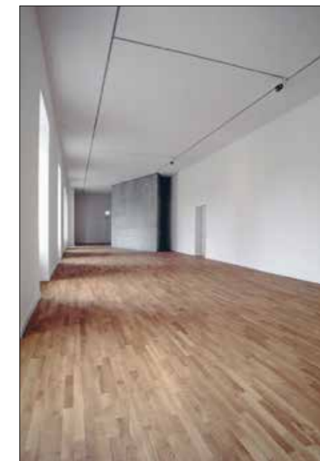
Parkiet dębowy impregnowany olejem twardym IRSA Natura Hartöl w Muzeum Żydowskim w Berlinie
